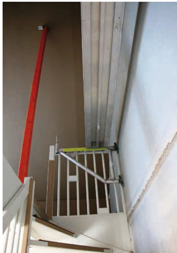
Trapgatconsole tijdens opbouw in open trapgat
