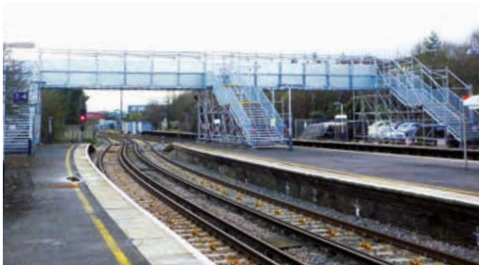
Système du pontage Allround de Layher passerelle piétonnier blindé de la gare.
