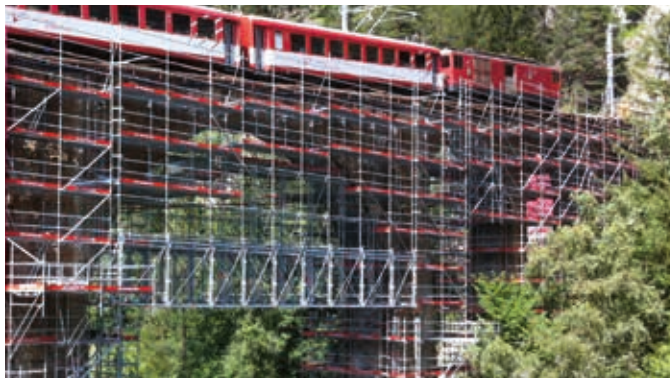
Soutien des système de pontage Allround sous un pont.
