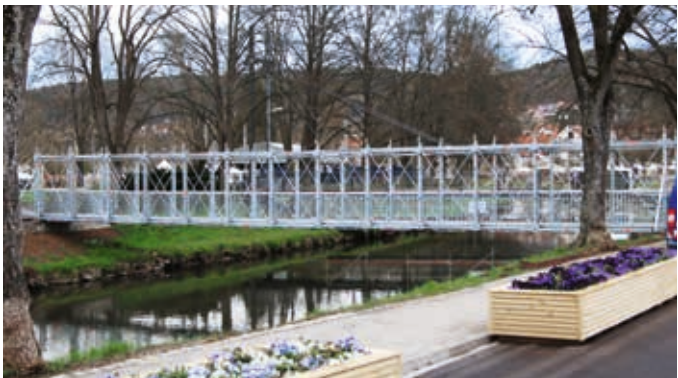
Système du pontage Allround de Layher passerelle temporaire.
