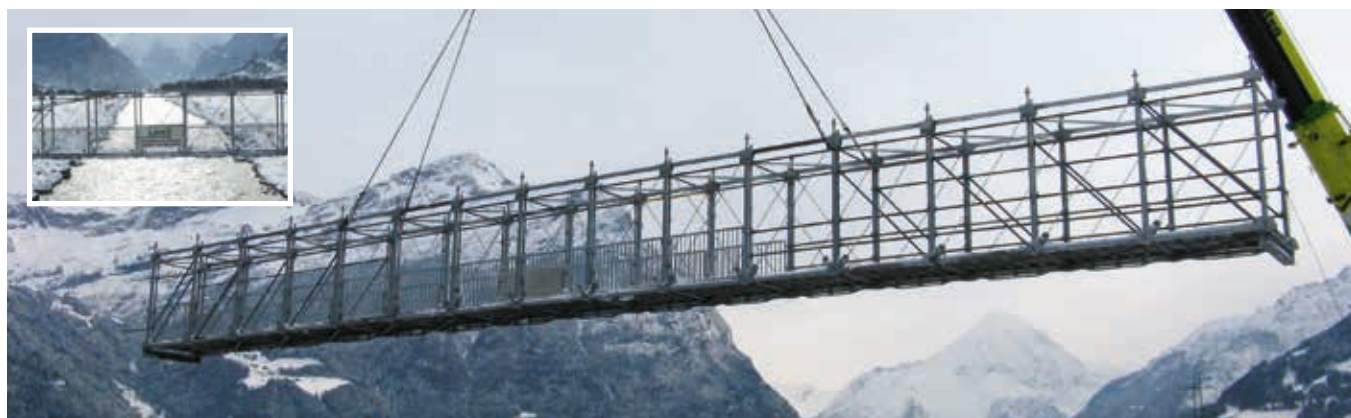
Système du pontage Allround de Layher passerelles pour piétons ouverte avec planchers en acier.
