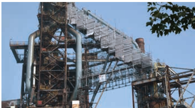
Construction „volant” pour soutenir la construction d'échafaudages d'industrie.
