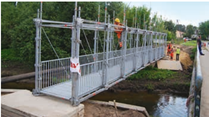
Système du pontage Allround de Layher passerelle ouverte et simple.
