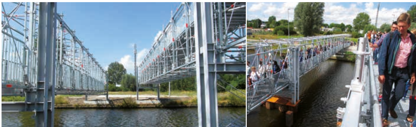
Système du pontage Allround de Layher passerelles pour vélos et piétons.
