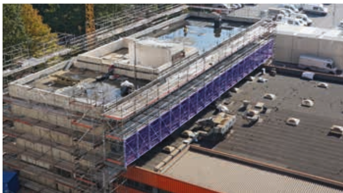
42 m construction système de pontage Allround avec un support central.
