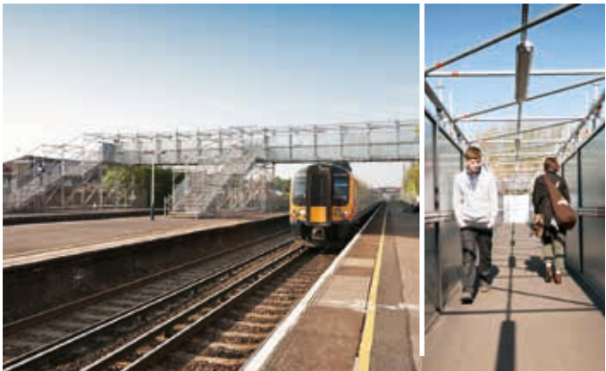
Système du pontage avec systemde de protect à l'intérieur pour protéger les piétons.
