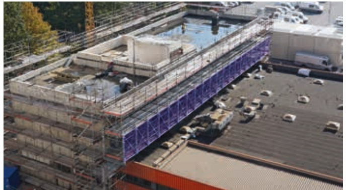
42 m brugconstructie in Allround gevelsteiger met een centrale ondersteuning.
