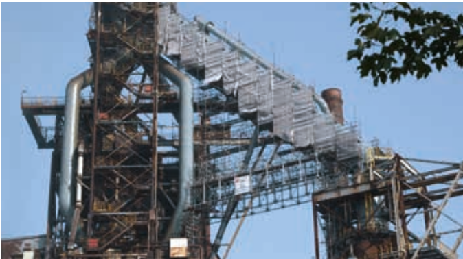
„Vliegende” constructie als ondersteuning van industrie-steigerconstructie.
