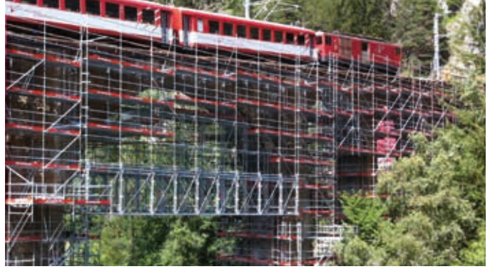
Ondersteuning van steigerconstructie onder een brug.
