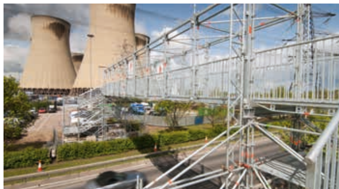
Loopbrug tussen de parkeerplaats en werkplek.
