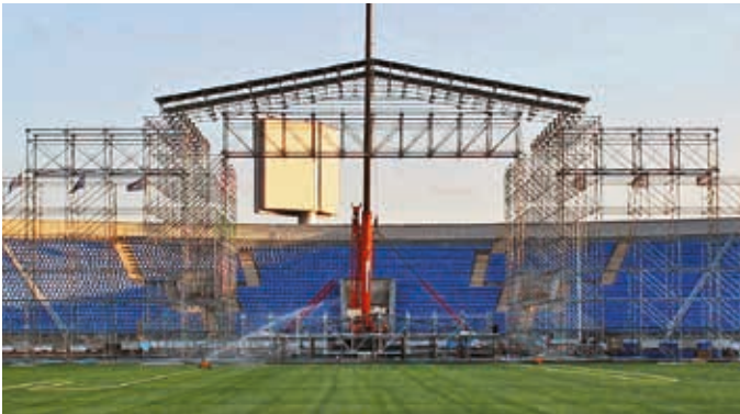
Constructie-onderdeel van het dak van een concertpodium.
