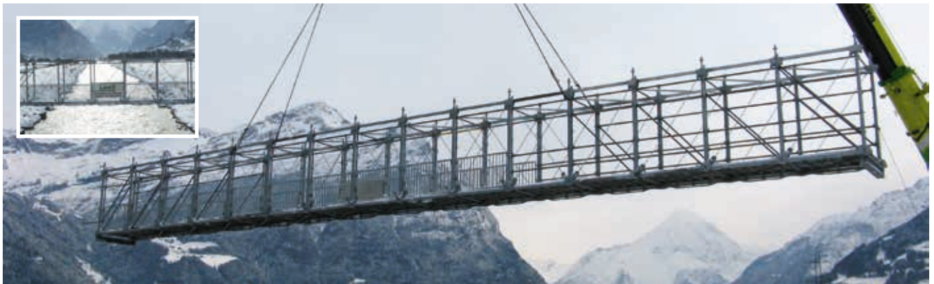
Het Allround Brugsystem als open voetgangersbrug met stalen vlonders.
