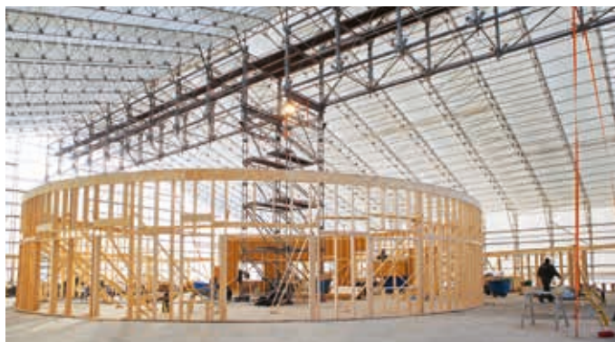
Nokondersteuning voor een Layher-zeilregeldak XL met een grote spanwijdte.
