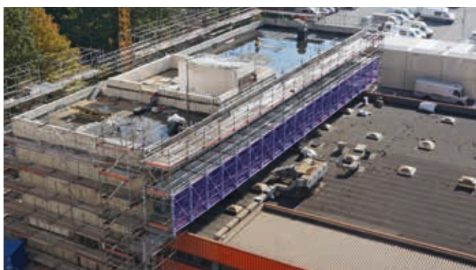
42 m brugconstructie in Allround gevelsteiger met een centrale ondersteuning.
