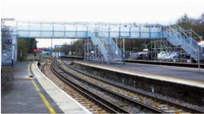
Afgeschermd voetgangersbrug spoorstation.
