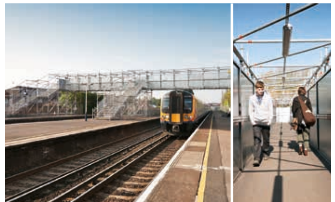
Loopbrug met protect gevelbekleding aan de binnenkant ter bescherming van voetgangers.
