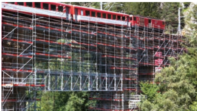
Ondersteuning van steigerconstructie onder een brug.
