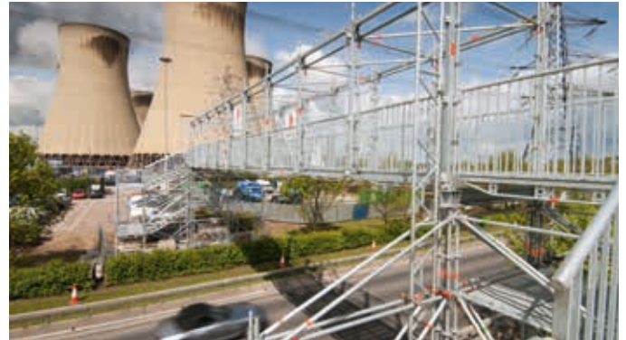
Loopbrug tussen de parkeerplaats en werkplek.
