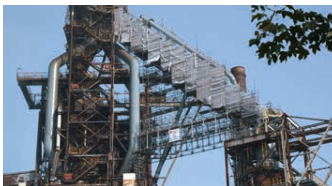
„Vliegende” constructie als ondersteuning van industrie-steigerconstructie.
