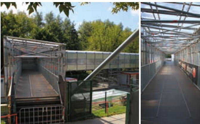
Combinatie met lichtgewicht cassette dak en protectsysteem – als VIP-ingang in stadion.
