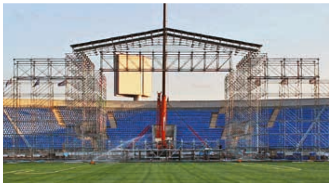
Constructie-onderdeel van het dak van een concertpodium.
