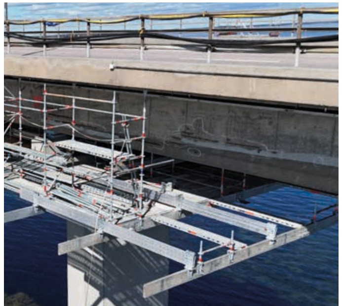
Vooruit de uitbouwmethode met FlexDeck-werkvloer tijdens de opbouwfase
